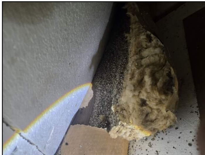
53. Possible Zonolite (vermiculite)
